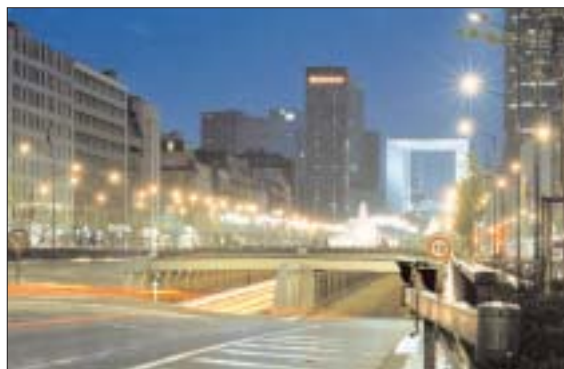
Tranchée couverte à Neuilly-sur-Seine (France)
