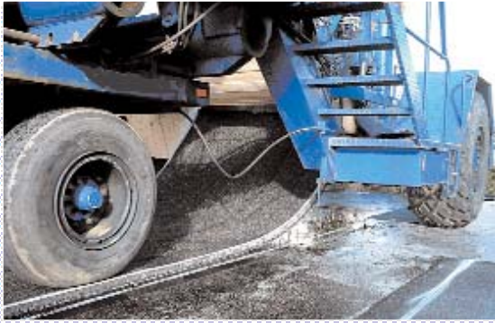
Programme route du futur Direction générale des Travaux Publics de Hollande
